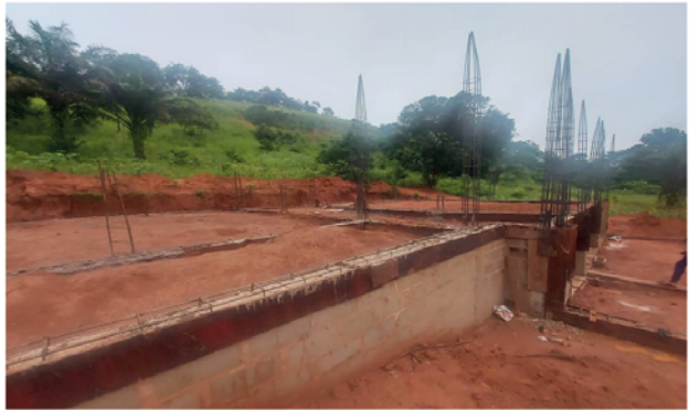
(Bilder: Die Fundamente der Schule sind gelegt.)
