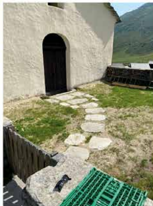
neu verlegt Zugangsplatten
