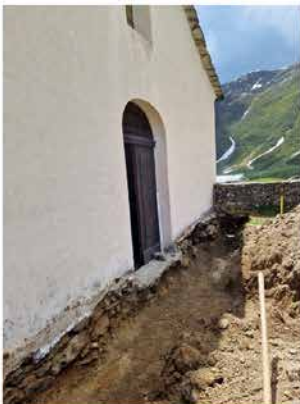
Drainage auf der Nordseite
