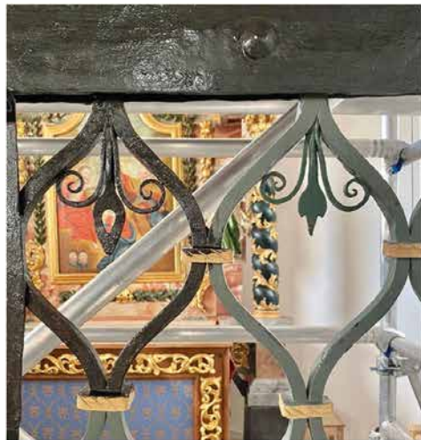
Saniertes Trenngitter mit erneuerten Blumen
